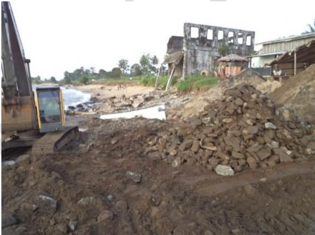
*Mise en place de la première section de GeoTextile mat (couleur blanche dans l'image) en dessous de l'ouvrage pour protéger la structure de béton à Buchanan*
