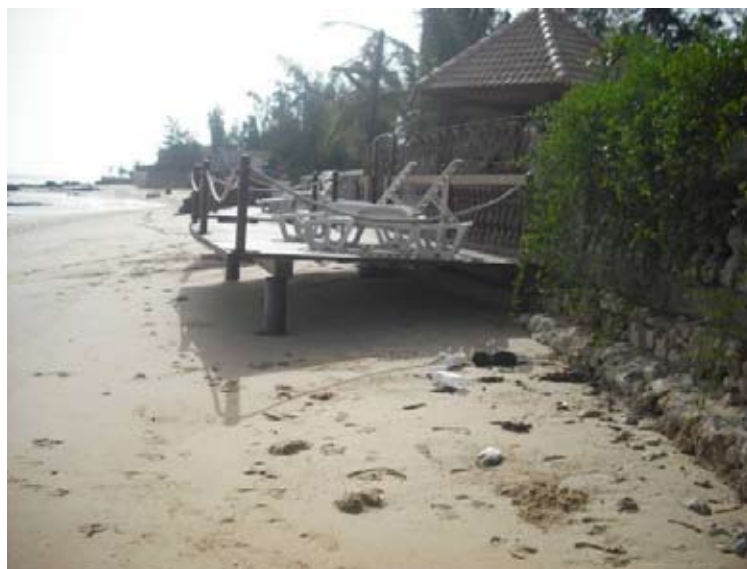
Photo 11 : enrochement avec des blocs en béton CSE juin 2010
