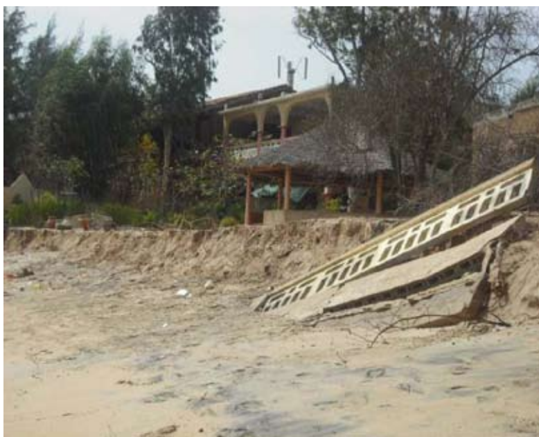
Photo 5 : Dommages sur le mur d'une maison à Ngaparou. CSE juin 2010
