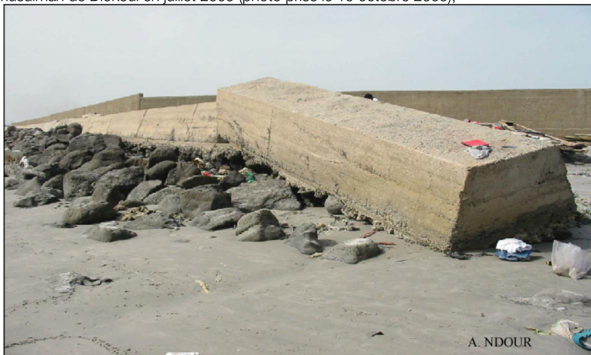
De l'autre côté ne subsistent que quelques segments du mur, la plupart s'étant affaissés avec mise à nu du géotextile sur lequel ils reposaient. En avant de ce mur, actuellement renversé, a été construit un nouveau mur vertical en béton armé d'une hauteur double du premier mais moins épais (photo 4).
