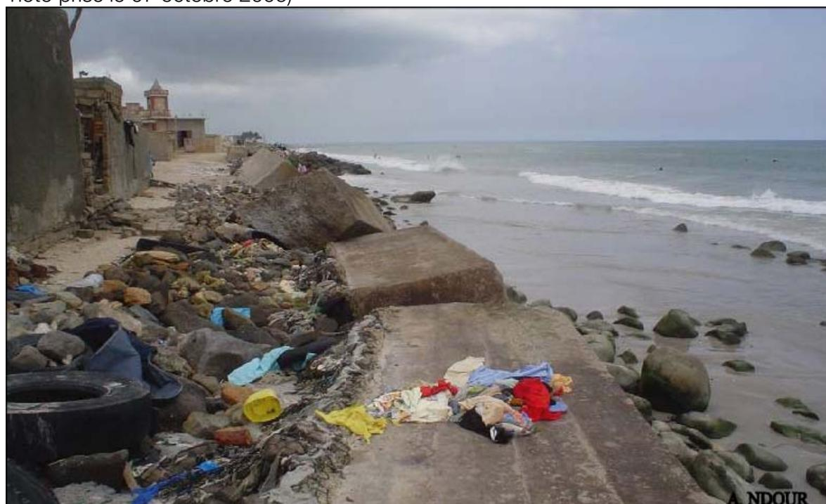
**Les murs en enrochements** (au niveau de Diokoul puis entre Keuri Souf et Bata) : il s'agit d'une digue trapézoïdale qui avait une largeur de 12 m à la base et de 5 m au sommet. Ce sommet qui se situait à +5 m au dessus du zéro hydrographique (Niang Diop, 1995) n'est actuellement qu'à environ à +3 m ou moins, suite à son affaissement et au déplacement des moellons de calcaire du sommet vers l'arrière par les houles (photo 5).
