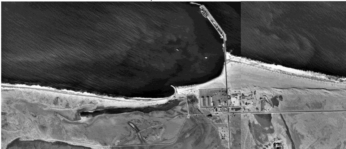
Photo1 : vue aérienne des abords du port de Nouakchott en 1991
