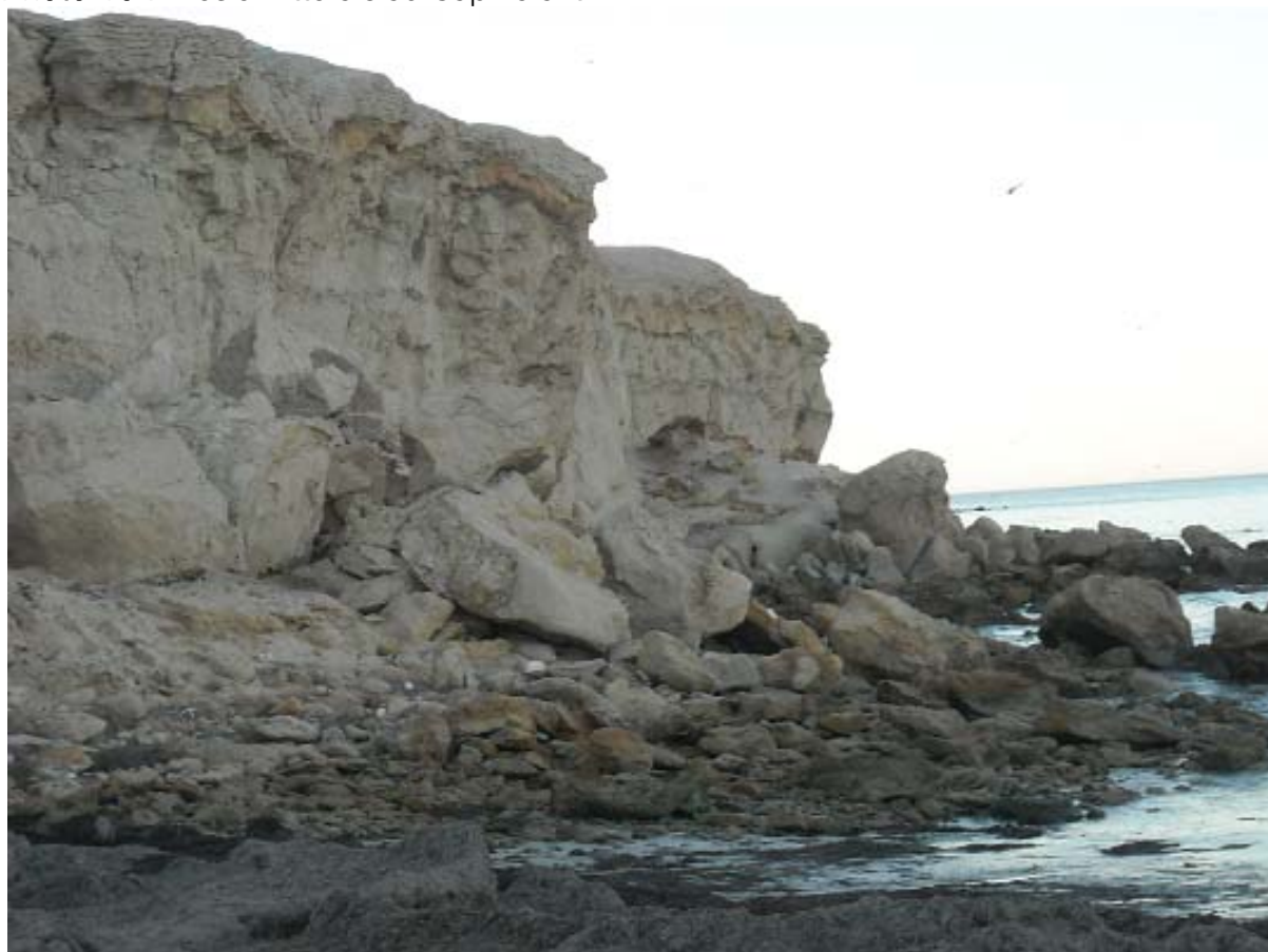
Photo 10 : Erosion littorale au Cap Tafari
