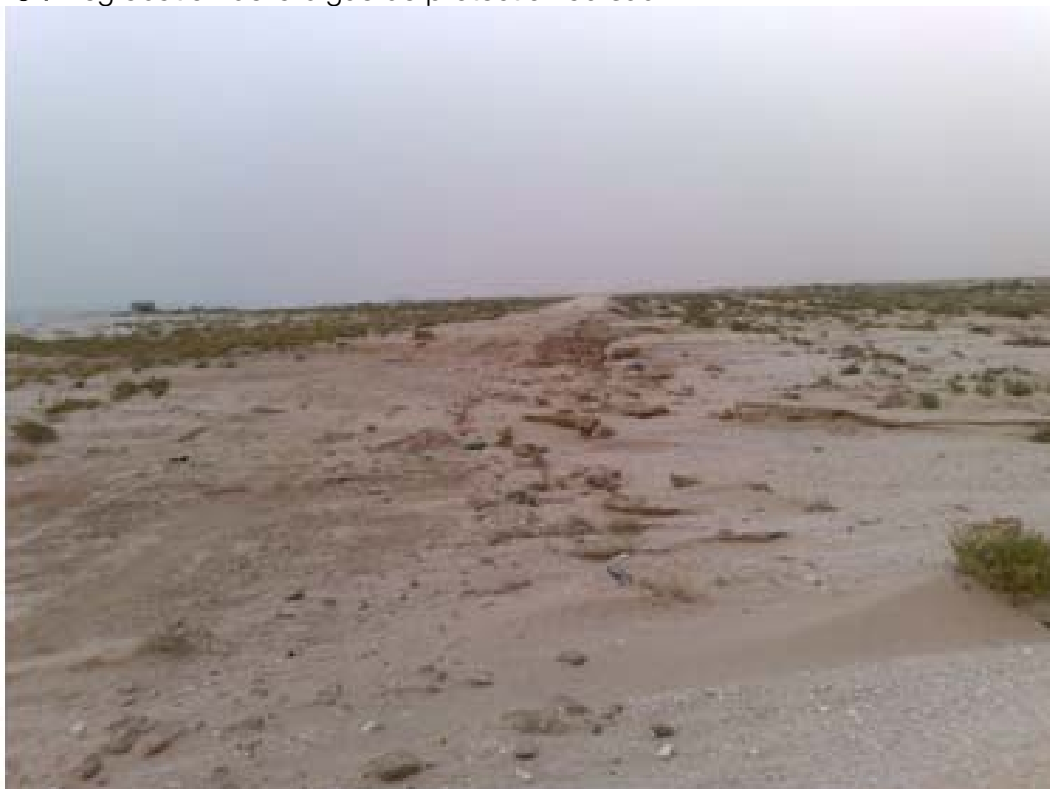
Photo 6 : Dégradation de la digue de protection au sud
