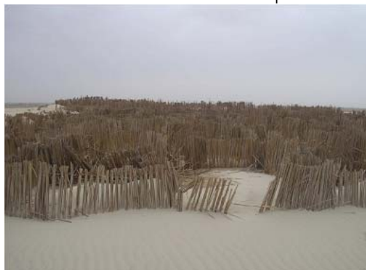
Photo 1 : Fixation du cordon par nattes de Typha
