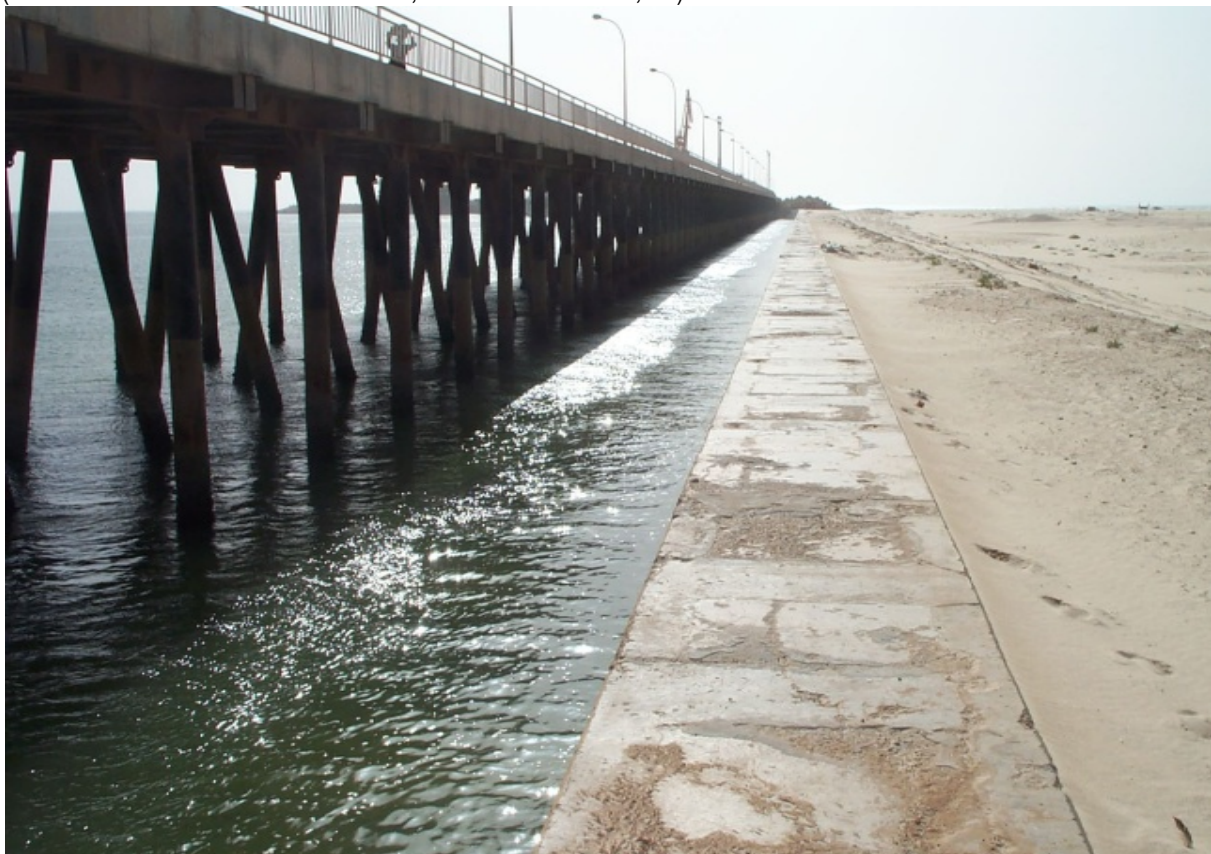
Photo 7 : Mur de blocage de sable du port construit en 1986 (coordonnées UTM X= 390975,59 Y = 1989608,90)
