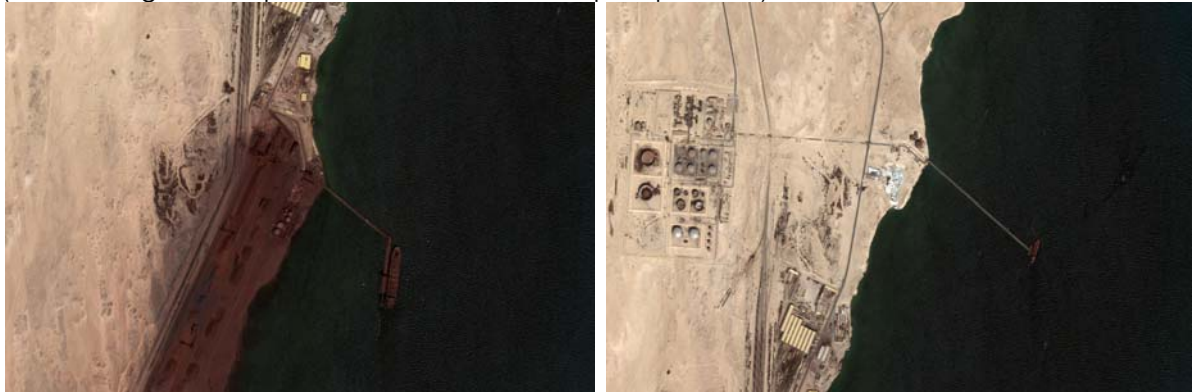
Photo 17 : Vues aériennes des infrastructures portuaires de Nouadhibou (en haut à gauche : port minéralier, à droite : port pétrolier).
