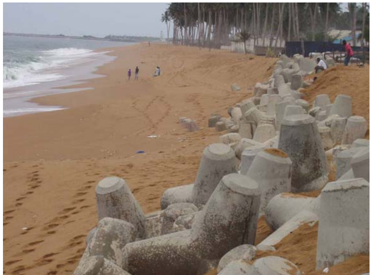
Figure 1 : enrochement de tétrapodes devant le Coco Beach. Port-Bouët, Abidjan (octobre 2003). Cliché auteur
