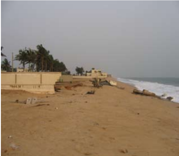
Photo 1 : Les derniers bâtiments résistants des résidences du FAGACE
