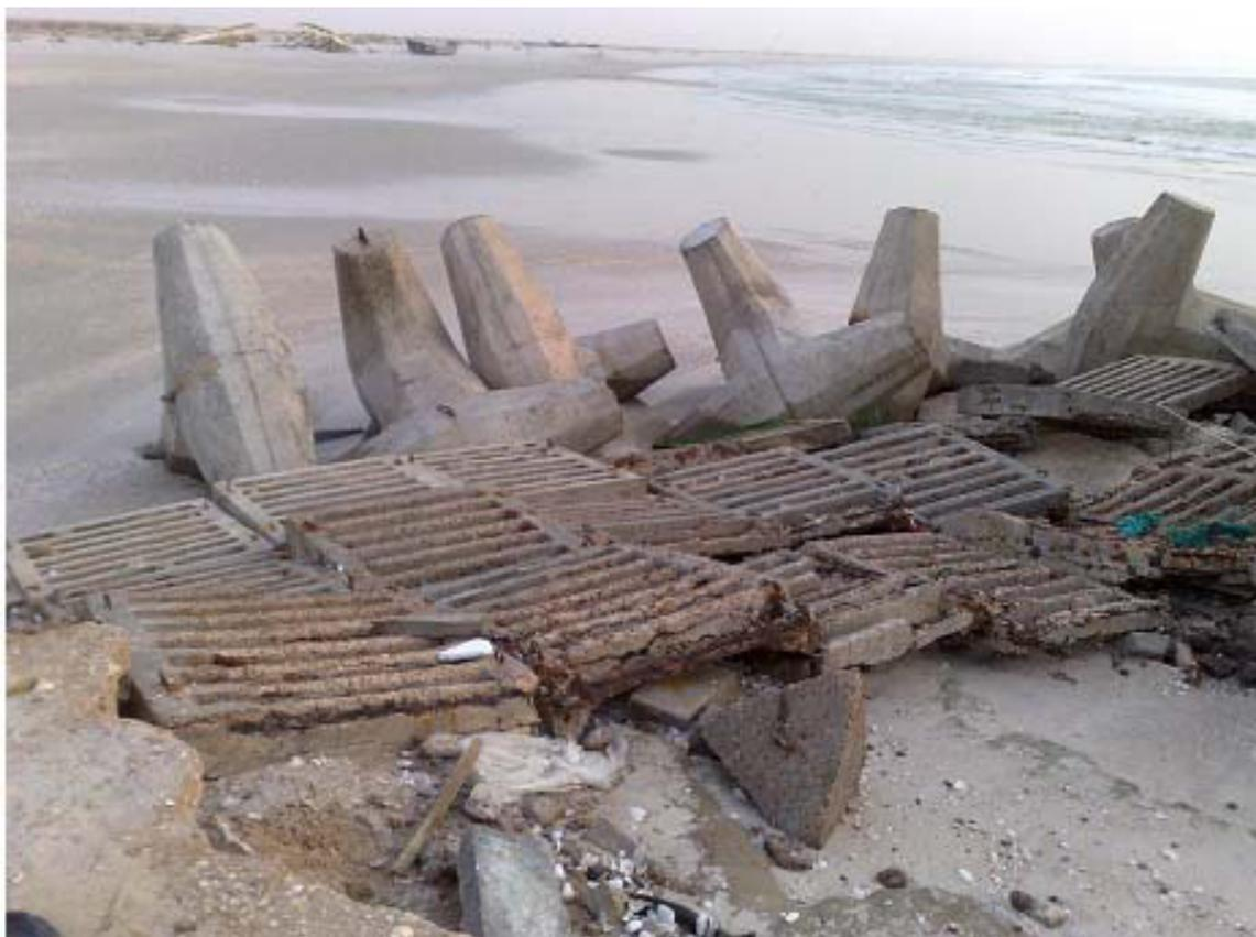
Photo 7 : Erosion et sapement de l'épi au sud du port
