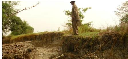
Photo 2: Attaque de la digue de protection de la plaine de Kaback par les assauts des vagues et des houles à Kaback
