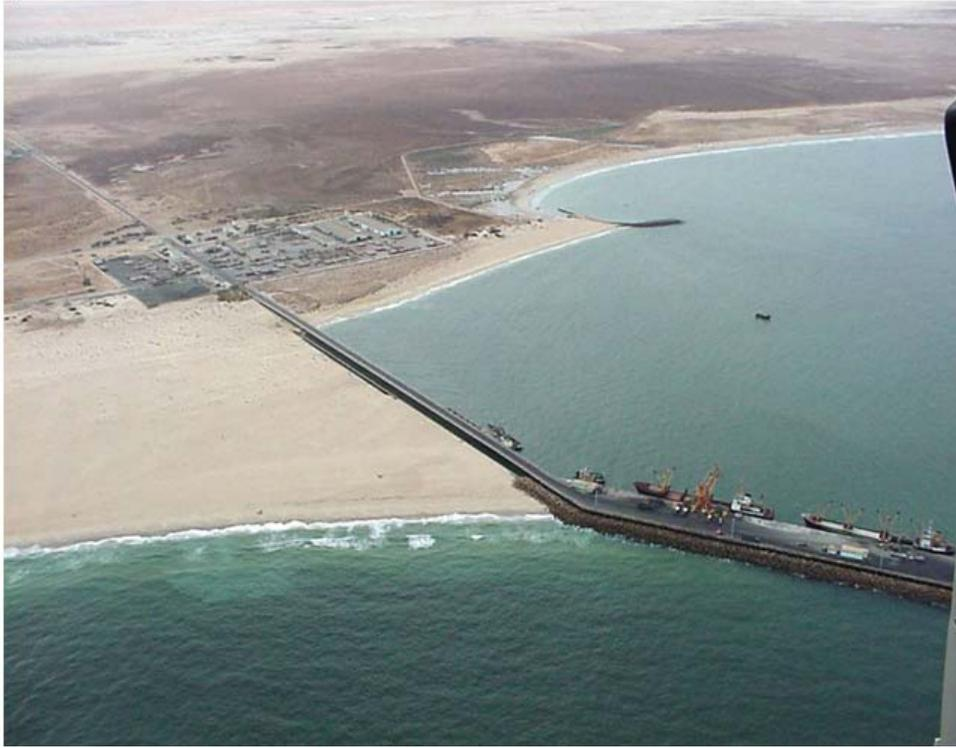
Photo 1 : Vue du port, ensablement au nord et érosion au sud.
