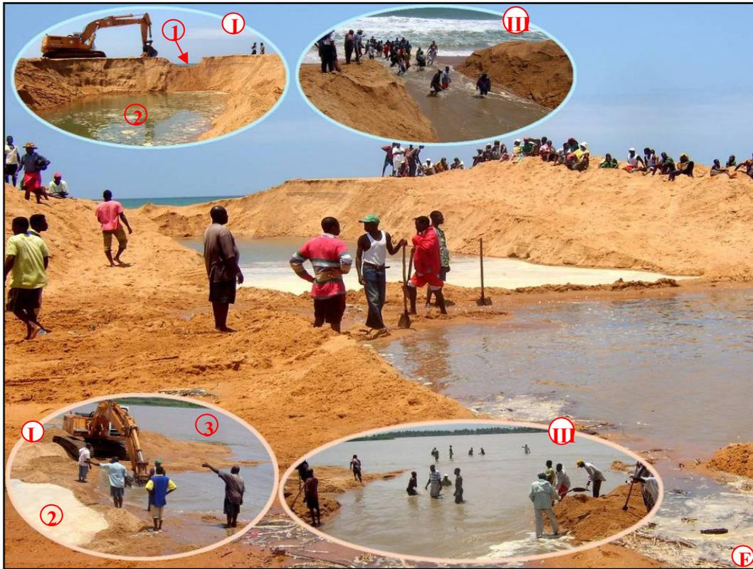
**Photo 2:** Photographies montrant les opérations d'ouverture d'embouchure artificielle à Avlo. Clichés LAIBI Raoul, 27/08/09
