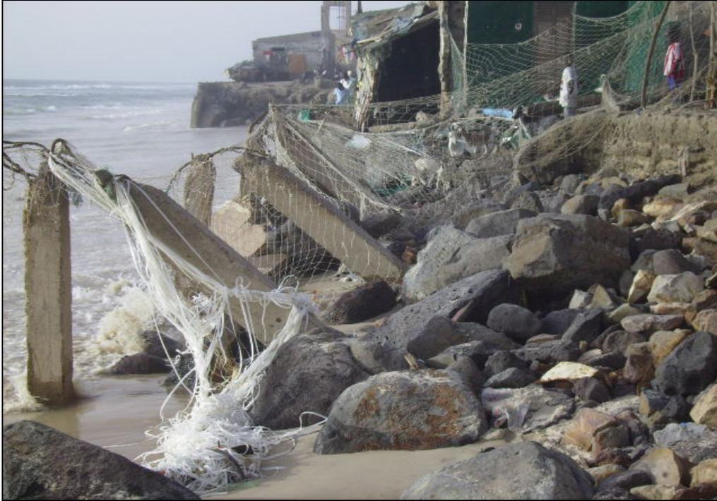
Ecroulement du mur de protection à Guet Ndar (construit en 1910 et déjà largement affaissé).
