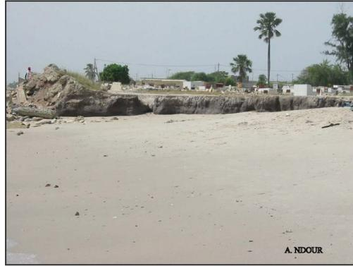
Micro falaise due à l'érosion à l'extrémité du mur en enrochements, au droit du cimetière de Thiawlène (effet de contournement) (photo prise le 19 octobre 2005)
